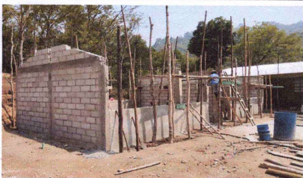
Foto 3: Avance de un 60% de la construccion de proyecto de remozamiento de dos aulas.
