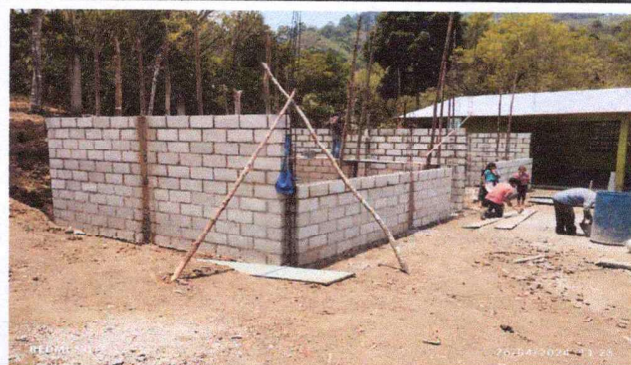
Foto 2: Avance de la construccion de remozamiento de dos aulas.
