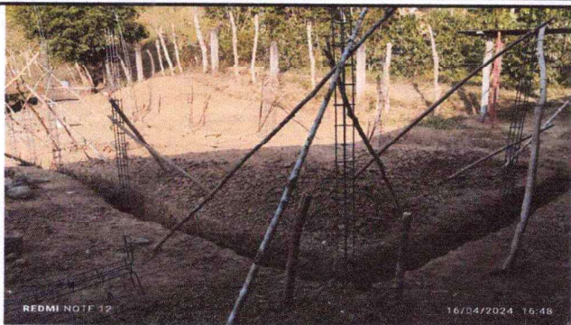
Foto1: Inicio de colocacion de columnas de la construccion de proyecto de remozamiento de dos aulas.
